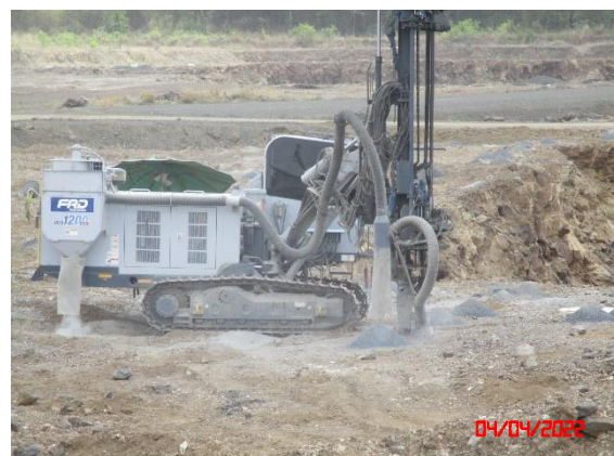
รูปที่ 2-4 เครื่องเจาะระเบิดที่มีอุปกรณ์เก็บฝุ่นติดไว้ที่หัวเจาะ
