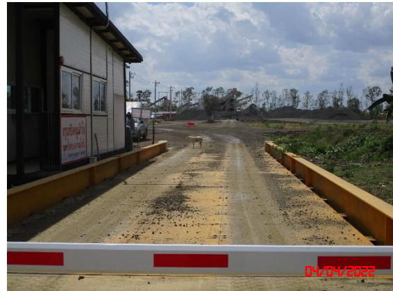
รูปที่ 2-11 จุดชั่งน้ำหนักบรรทุกทุก
